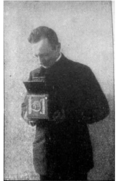
b) Richtige Haltung einer Spiegelreflexkamera.
